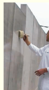
Nach der zweiten Applikation mit einem Pinsel gleichmäßig verstreichen.
